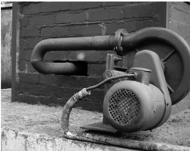
Figure 5. Ouverture permettant l'entrée d'air dans la chambre de combustion. L'admission d'air peut être accrue par effet Venturi à la mise en service du ventilateur (ici un ventilateur électrique).
