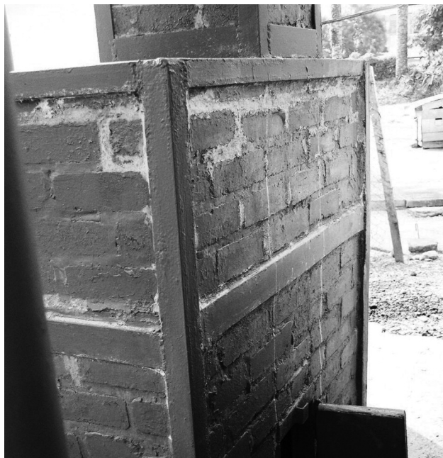
Figure 2. La chambre de post combustion, surmontée de sa cheminée, et l'ouverture permettant l'entrée d'air ou de combustible.
