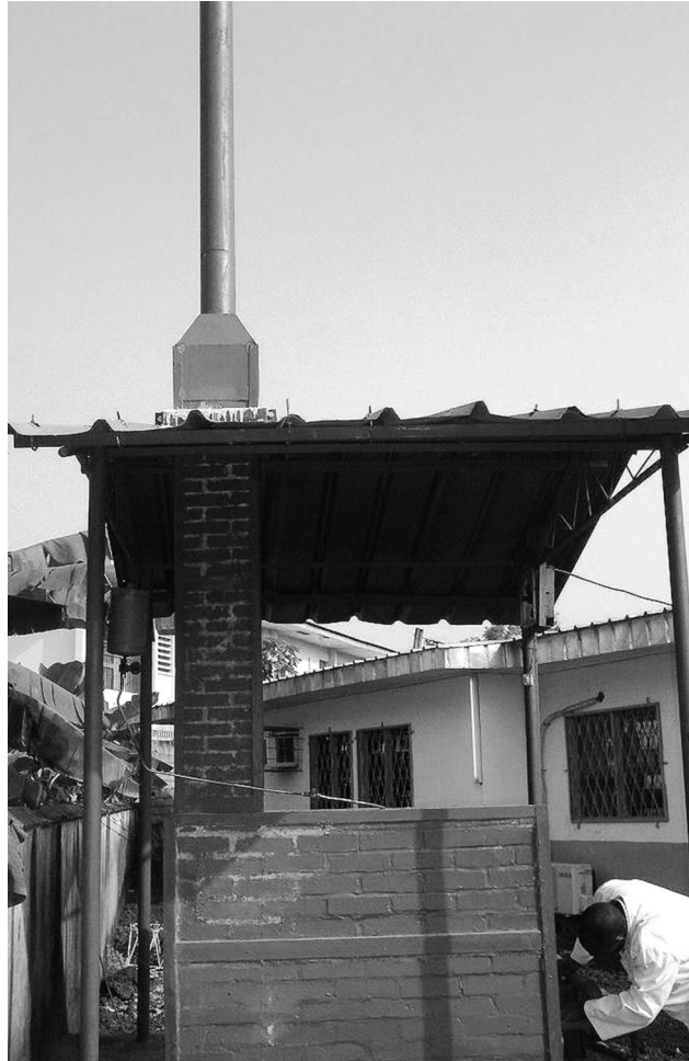
Figure 6. Vue d'ensemble de l'incinérateur sous son préau de protection, pendant une manipulation. On distingue au-dessus la cheminée, de briques réfractaires surmontée d'une buse, et le réservoir de carburant à gauche de la cheminée.
